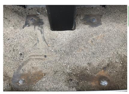
PUDDLE WELD ON TOP BASE PLATE SO PROFILE DOESNT INTERRUPT ROCK MAINTENACE STRIP PROFILE ABOVE
